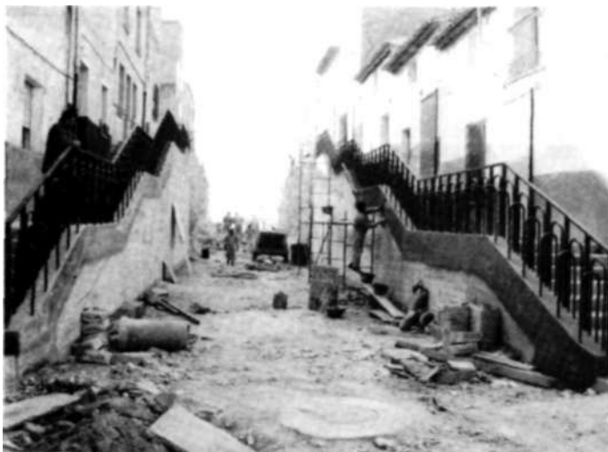
Obras de la comunicación de la calle Juan Ortuño. Foto "El Molino".
