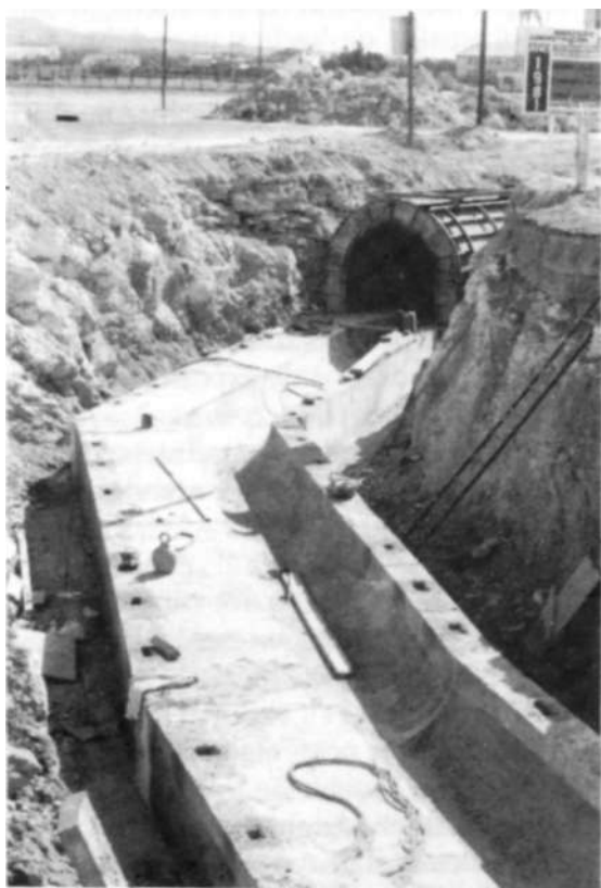
Obras del gran colector.
